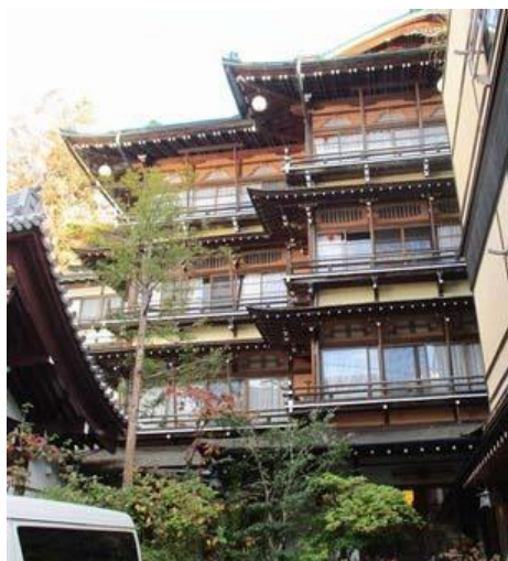
金具屋の建物
