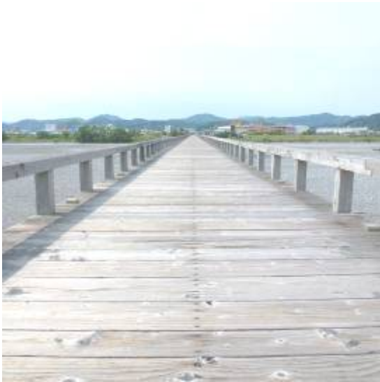
大井川に架かる木造世界最長（897.4m）の橋
