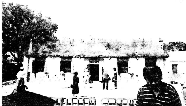
(水師営：向って左端の窓部屋が会見室)
